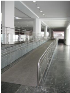
Abb. 14: Rampe in der Eingangshalle (Untergeschoss)
