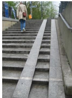
Abb.3: Treppe zum Haupteingangsbereich
