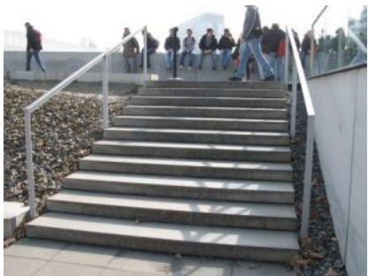
Abb. 24: Treppe zum Ausstellungsgraben
