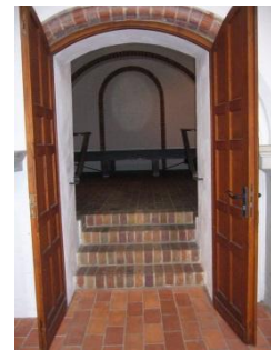
Abb.10: Treppe zur Sakristei
