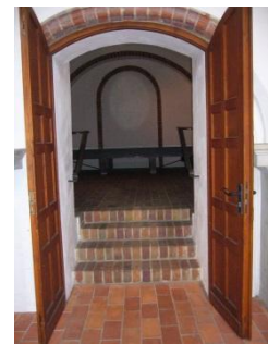
Abb.10: Treppe zur Sakristei
