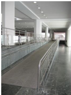
Abb. 14: Rampe in der Eingangshalle (Untergeschoss)
