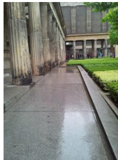
Abb. 3: Rampe im Eingangsbereich
