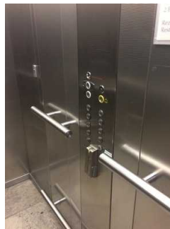
Aufzug Erdgeschoß - WC - Zimmer
