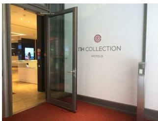
Tür am Haupteingang für Rollstuhlnutzer
