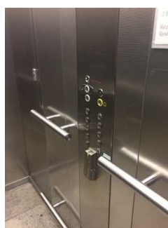
Aufzug Erdgeschoß - WC - Zimmer
