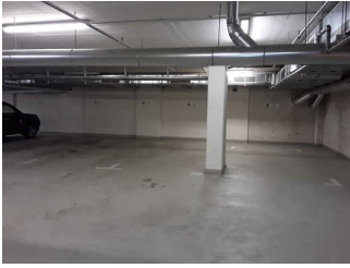
Parkplatz für Menschen mit Behinderung Tiefgarage
