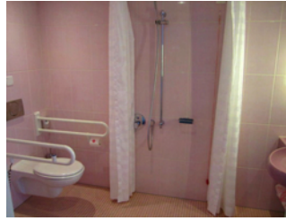
Sanitärräume der Zimmer 350, 549 und 550
