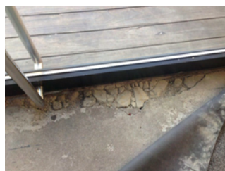
Tür zwischen Galerie, Ebene 2 und Terrasse
