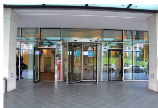
Eingangstüren, mittig Drehtür, rechts und links davon barrierefreie Flügeltüren
