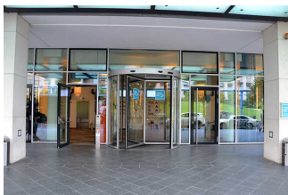
Drehtür am Eingang mittig
