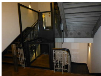
Hublift zwischen Nebeneingang und Rezeption
