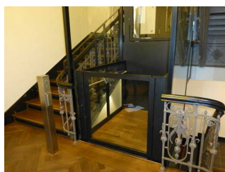
Hublift zwischen Nebeneingang und Rezeption
