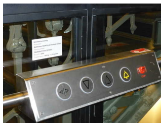
Hublift zwischen Nebeneingang und Rezeption
