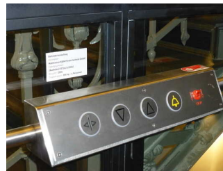
Hublift zwischen Nebeneingang und Rezeption
