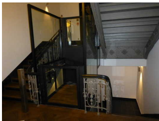
Hublift zwischen Nebeneingang und Rezeption
