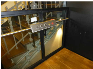
Hublift zwischen Nebeneingang und Rezeption
