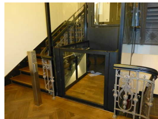
Hublift zwischen Nebeneingang und Rezeption
