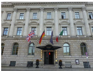
Haupteingang Hotel de Rome (Behrenstr.)
