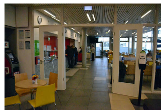
Tür in Kantine
