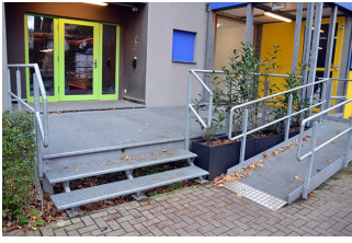
Stufen am Übergang H1-H2
