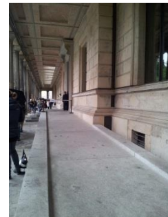
Abb. 4: Rampe im Eingangsbereich
