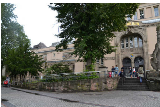
Außentreppe am Aquarium (Zooseite)
