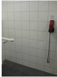
Öffentliches WC Terminal A, Gate 0
