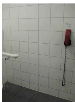
Öffentliches WC Terminal A, Gate 0
