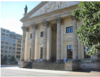
Gedarmenmarkt: Pflaster (u.a. Bereich Deutscher Dom)
