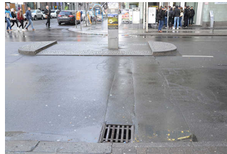
Querungsstelle mit Verkehrsinsel, rechts Zugang zur Fläche vor der Baracke
